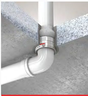
ISITHERM Rohrmanschette BBR in Massivdecke mit 90° Bogen mit HBT Brandschutzmörtel M3 eingemörtelt
