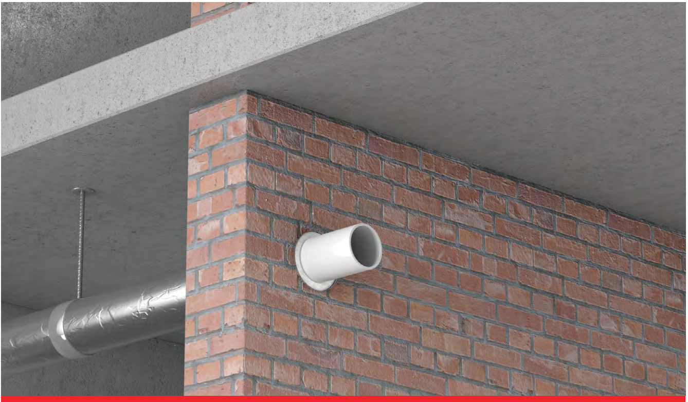
Durchführung von brennbaren Rohren nach Abschnitt 4.3 MLAR
