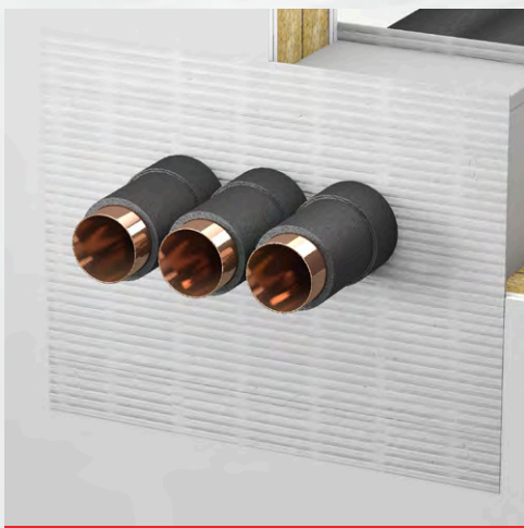
Nichtbrennbares Rohr mit brennbarer Isolierung in dem ISILASTIK B5 Kombischottschott
