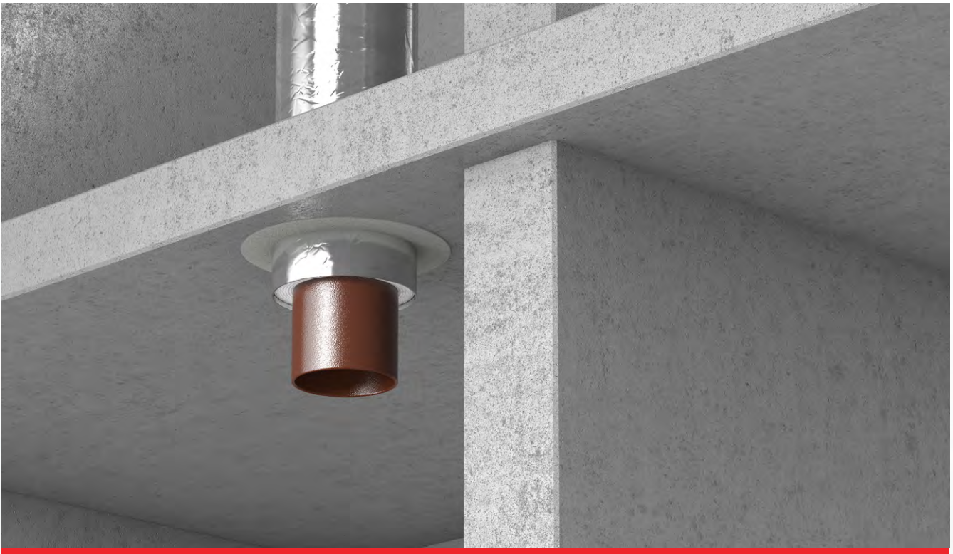
Durchführung von nichtbrennbaren Rohren nach Abschnitt 4.3 MLAR
